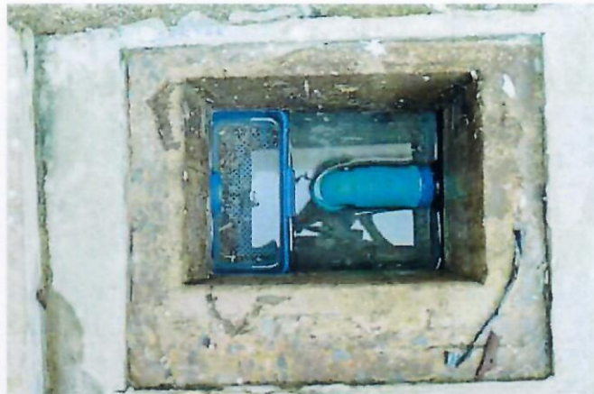
รูปที่ ๓ บ่อดักไขมันแบบวงขอบซีเมนต์ - ทรงสี่เหลี่ยม
